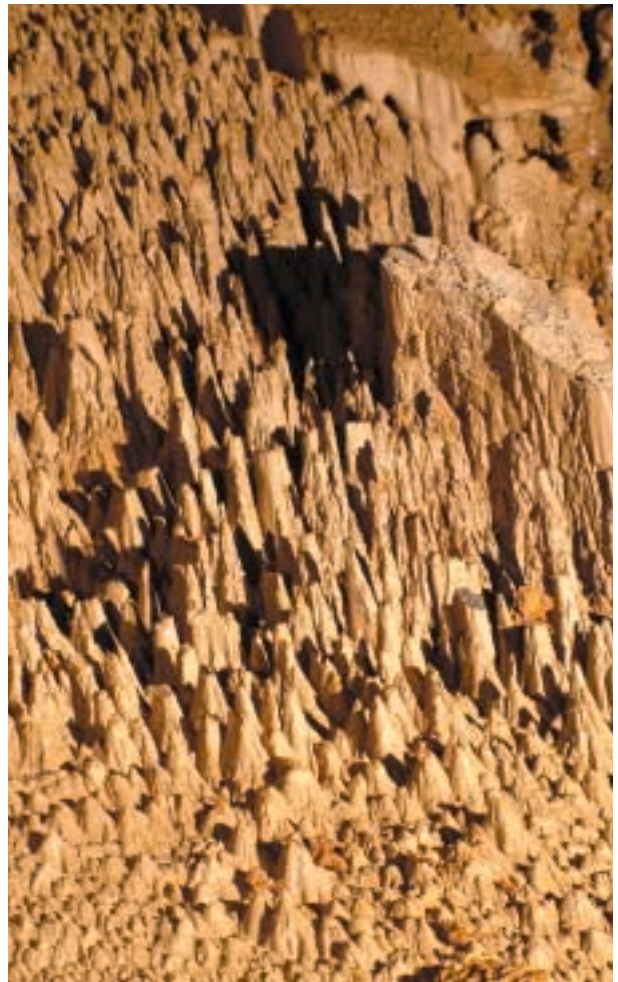
Barlangi „zápor” nyomai / Traces of a pipeline-damage Spuren eines wahrscheinlichen Wasserleitungsbruches
