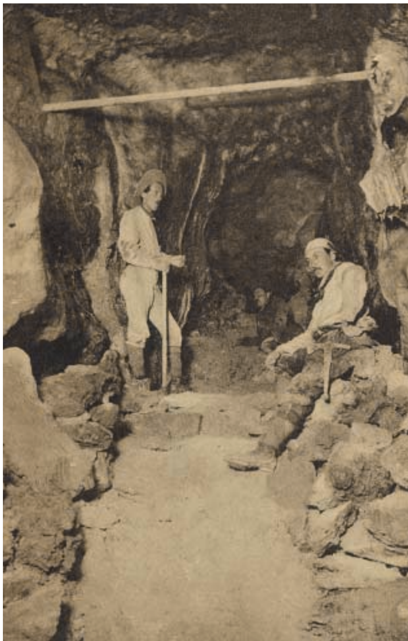
A Meseország kiépítése Construction work at Fairyland / Der Ausbau des Märchenlandes
